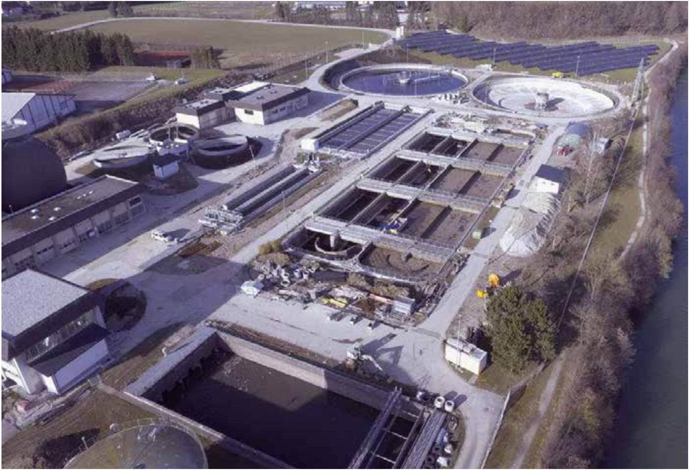
Die Kläranlage Steyr wird generalsaniert. © Flugaufnahme Baustelle 5.4.2018, Felix Seitlinger
